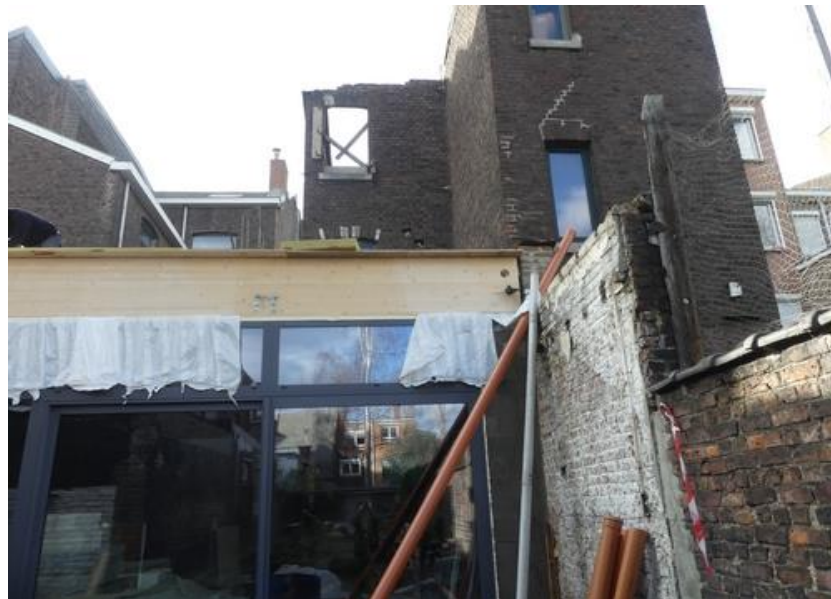
Début des travaux
