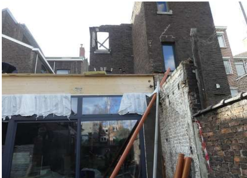
Début des travaux
