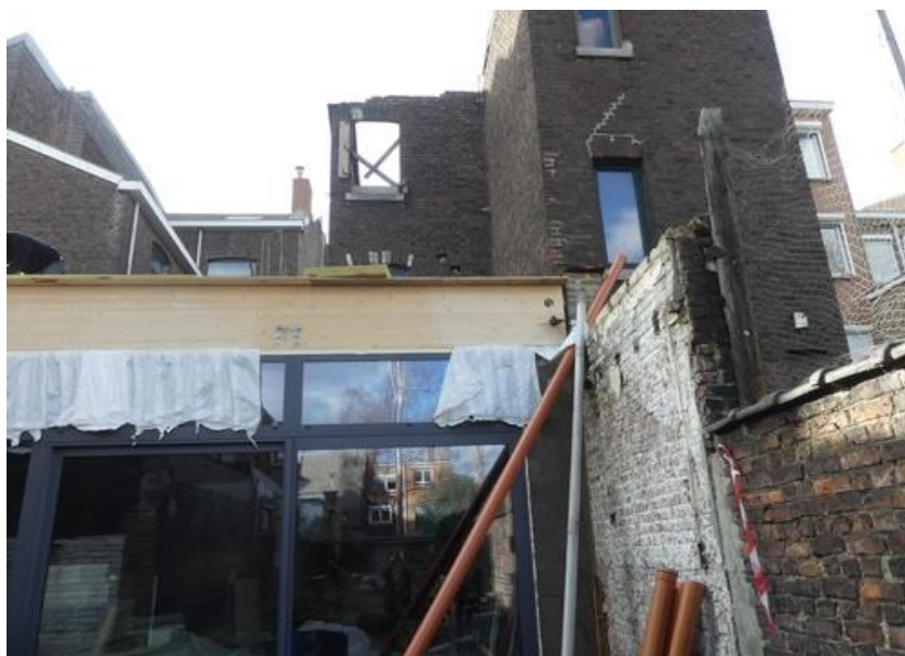
Début des travaux
